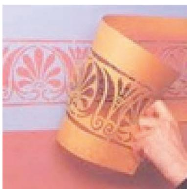
Рис. 171. Нанесение рисунка с помощью трафарета
