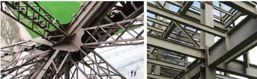
Рис. 114. Применение заклёпочных соединений
