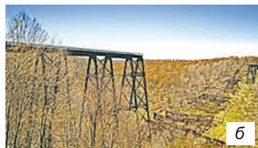
Рис. 152. Последствия ржавления: а – разрушенный Серебряный мост в Западной Вирджинии; б – разрушенный мост Кинзу в Пенсильвании
