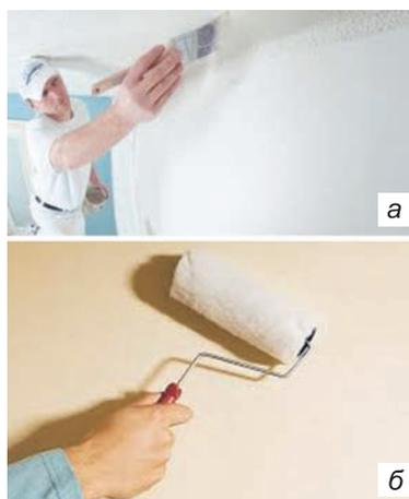
Рис. 168. Приёмы нанесения покрасочных смесей: а – флейцем; б – валиком
