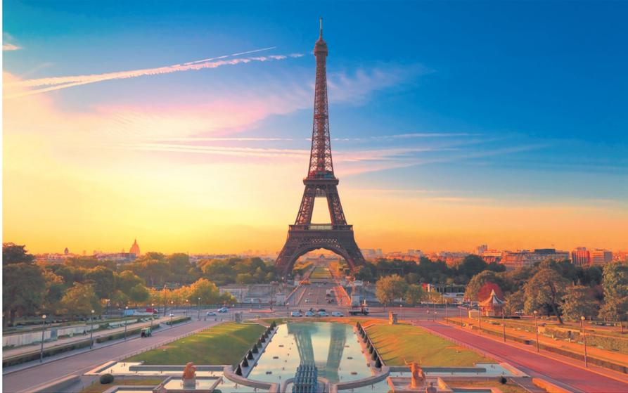
Véritable prouesse technique, la tour mesure 320,75 m avec son antenne radiotélévision et pèse 6 400 tonnes. Elle se compose de 15 000 pièces métalliques réunies par 2 500 000 rivets. La restauration de la tour est effectuée tous les 7 ans et nécessite 45 tonnes de peinture.
