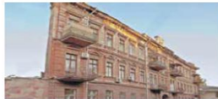
Будинок-стіна в Одесі
